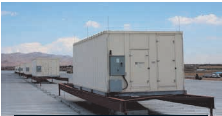
Velike hale strežnikov mnogokrat izdajajo le hladilni sistemi na strehah, ki so ozko grlo pri tlačenju računalnikov na majhen prostor. Vir: Datacenter Journal .
